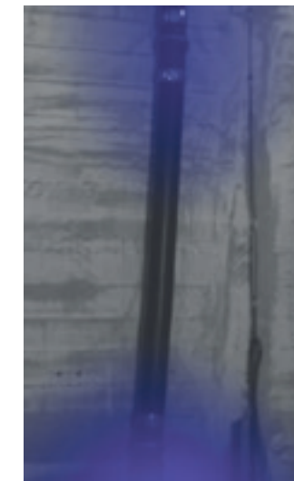
↑ Installation mit Geberit Silent-db20 Offset Formstück
